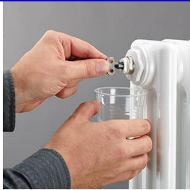
Entlüftung des Heizkörpers viertel Drehung bis max. halbe Drehung nach links
